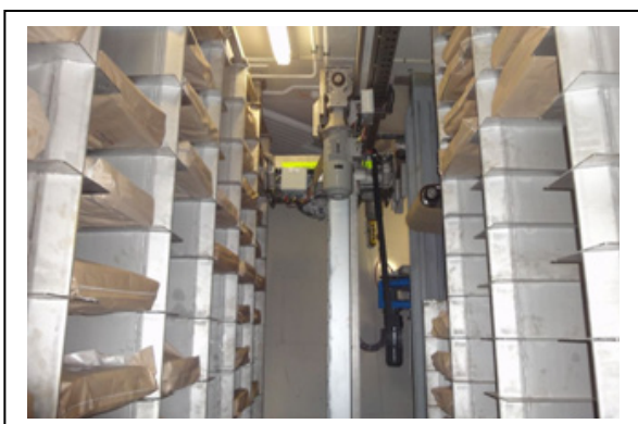
Bilde 9 Mellomlager med reolrobot i midten
